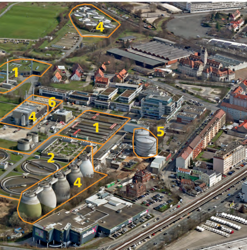
Das Klärwerk 1 aus der Luft. Foto: Nürnberg Luftbild Hajo Dietz.
