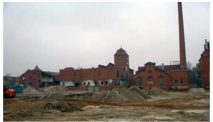
Abriss der Tucher-Brauerei 2011 ...
