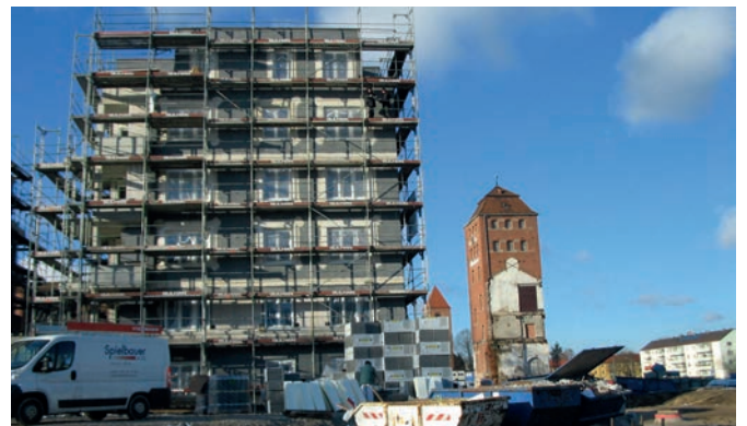
... und Neubau der Wohnanlage 2013.
