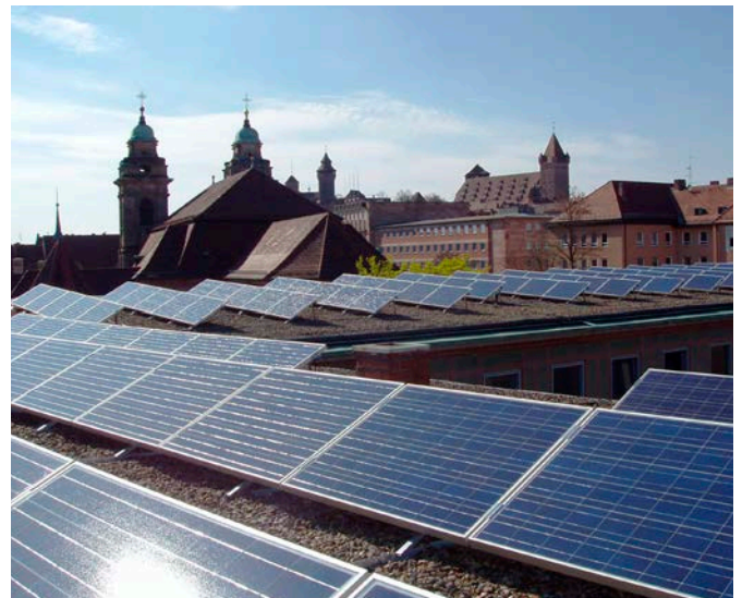
Photovoltaikanlage auf dem Dach des Willstätter-Gymnasiums
