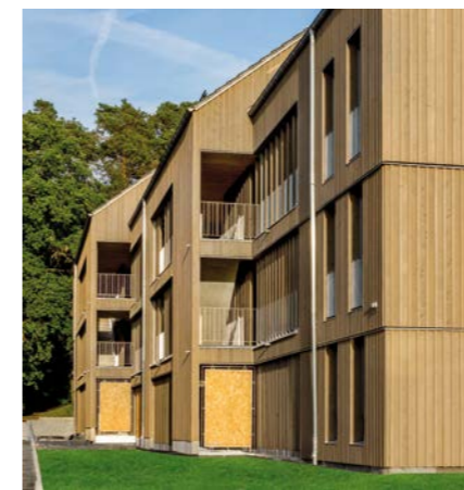
EBLW-Heinrich-Held-Straße, St. Gundekar-Werk: 41 geförderte Wohneinheiten für 1 bis 7 Personen-Haushalte, in vorgefertigter Holzbauweise mit Gemeinschaftsraum und einem begrünten Hof
