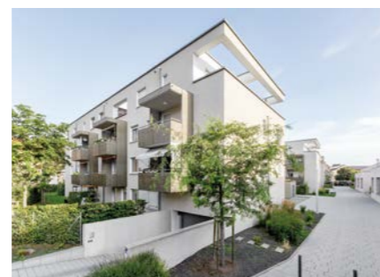
IQ-Pfälzer Straße, Joseph-Stiftung: Wohnbebauung mit 49 geförderten und einer freifinanzierten Wohnung für Familien mit bis zu vier Kindern mit einem besonderen Freiraumkonzept
