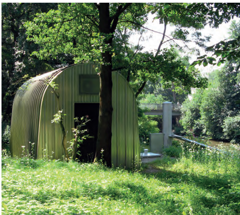
Die im Jahr 2001 errichtete Messstation Neumühle an der Regnitz.
