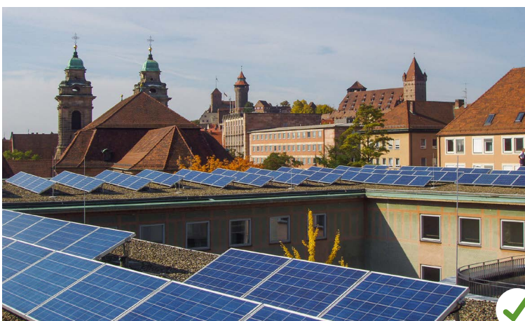
Ensemble Altstadt – Willstätter Gymnasium: PV-Anlage nach Süden aufgeständert
