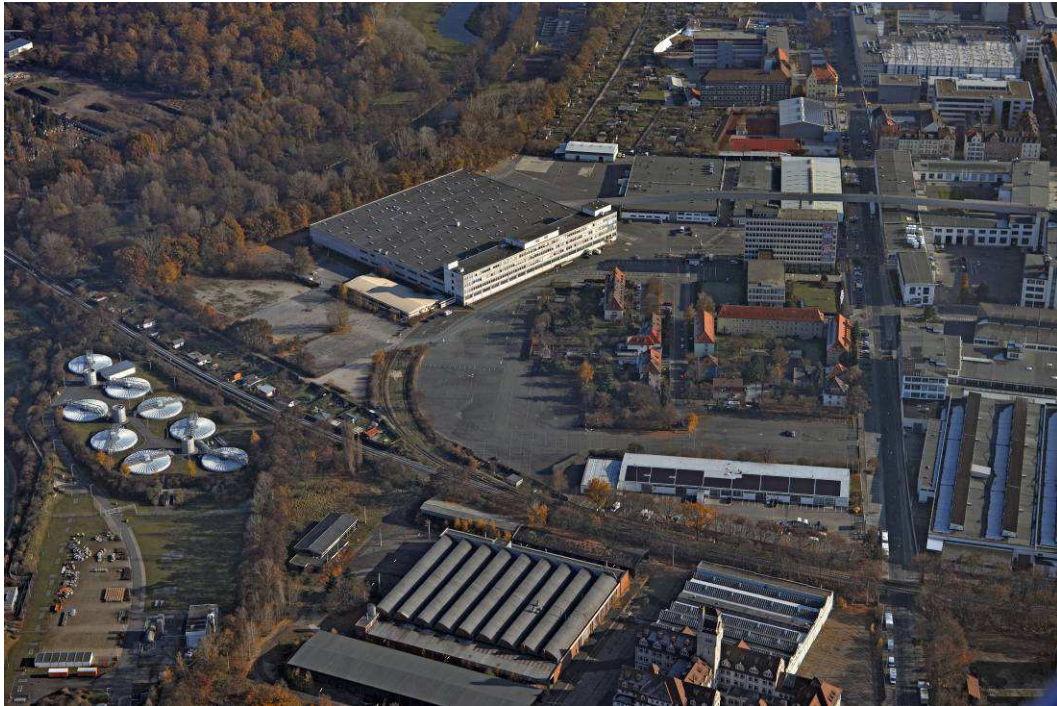
AEG-Nordareal von Westen, im Vordergrund Klärwerk I und ehem. VAG-Straßenbahndepot, Fuchsstraße Luftbild Nürnberg / Hajo Dietz 2011
