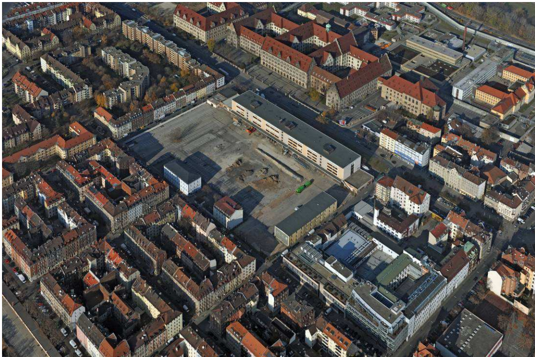
Ehemalige Möbelquelle von Südosten
