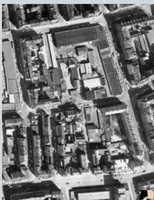
Fabrik "Mammutgelände" Luftbild 1969
