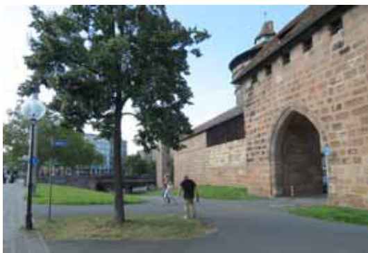
Beispielhafte Maßnahme im Spittlertorgraben: Gestaltung Graben, Herstellung bzw. Aufwertung von Spiel- u. Sportflächen
