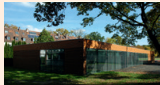
Abb. 4.10: Anbau am Neuen Gymnasium in Passivhausbauweise mit Sonnenschutz durch Jalousien im Scheibenzwischenraum.
