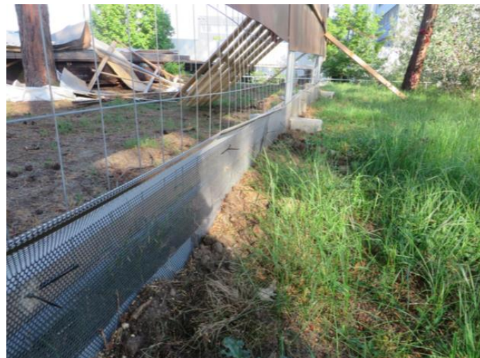
Das nach außen überkletterbare Lochblech am Fuß des Bauzauns, links der Eingriffsbereich, rechts die Maßnahmenfläche
