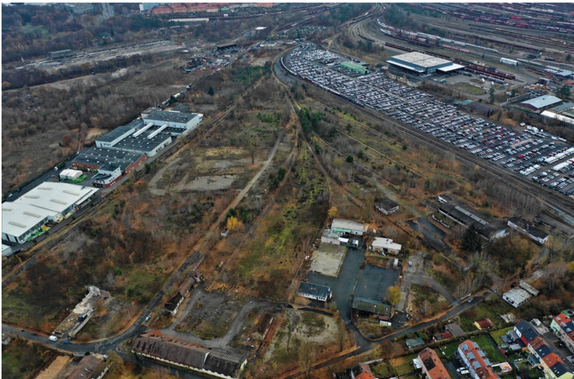
Gelände Brunecker Straße der künftigen Universität
