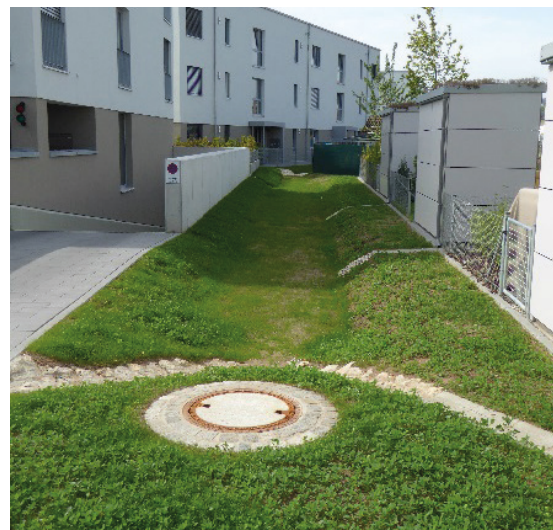
Muldenversickerung Großreuth bei Schweinau
