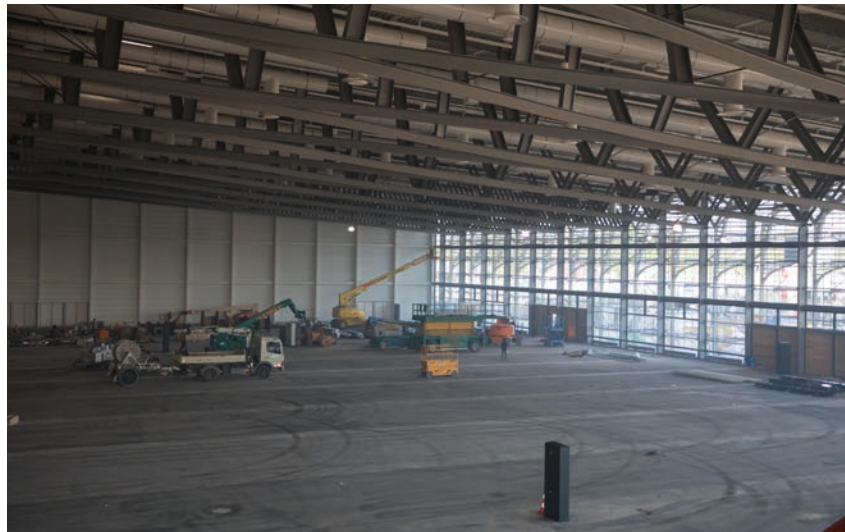
Baustelle der neuen Messehalle 3C
