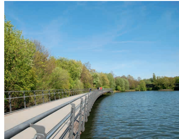
Der neue Boulevardsteg erschließt die Uferzone neu und dient gleichzeitig der Wasserführung.
