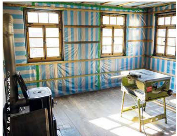
die meisten Dämmstoffe eine Dampfsperre. Eine kapillaraktive Dämmung benötigt dagegen keine Dampfbremse, weil die Feuchteregulierung über die Kapillarwirkung des Materials funktioniert. Wenn eine Austrocknung der Wand nach innen nötig ist, wie zum Beispiel bei Fachwerkkonstruktionen oder anderen nicht schlagregendichten Außenwänden, dann sollte auf eine diffusionsoffene Innendämmung mit feuchtevariabler Dampfbremse zurückgegriffen werden.
