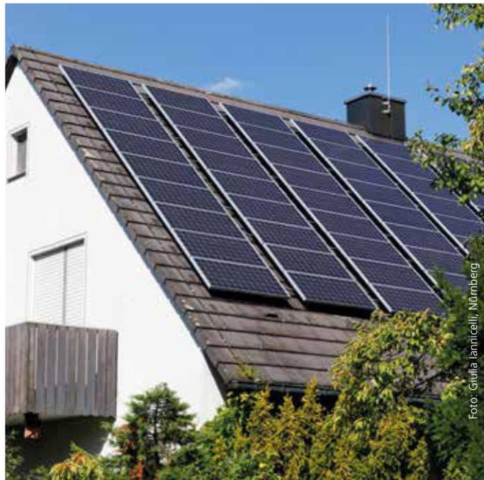
22 % (monokristalline Zellen). Auch eine ungünstige Dachneigung, etwaige Verschattungen durch Bäume, Nachbarhäuser o. ä. können den Stromertrag deutlich reduzieren.
