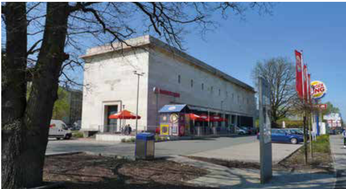
Umrisse des ehemaligen Adlers mit Hakenkreuz über dem Eingang des Umspannwerks auf der Schmalseite. Der 1937–39 erstellte Bau von Albert Speer wird heute von einem Schnellrestaurant genutzt, 2009. (Museen der Stadt Nürnberg)
