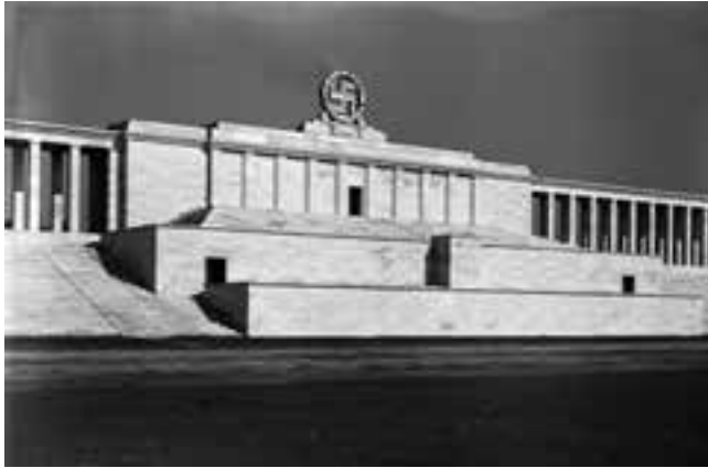
Die Zeppelintribüne zu ihrer Erbauungszeit, 1938, Foto: Arthur Schlegel (Bayerisches Landesamt für Denkmalpflege)
