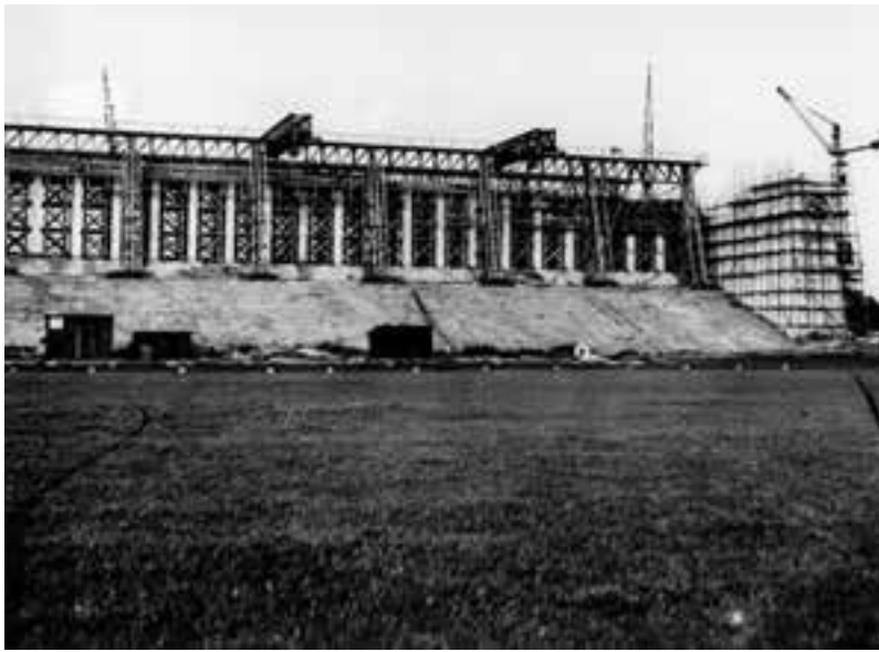
Die Zeppelintribüne im Baugerüst, um 1935 (Museen der Stadt Nürnberg)
