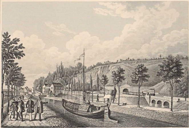
Der Kanal bei Erlangen gegen das Kanalmonument u. den Ludwig Süd-Nord Eisenbahntunnel.
