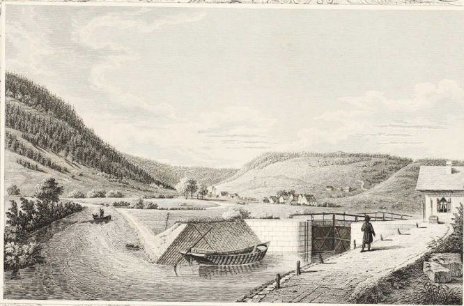
EINMÜNDUNG des Kanals in die Altmühl bei Biehart.
