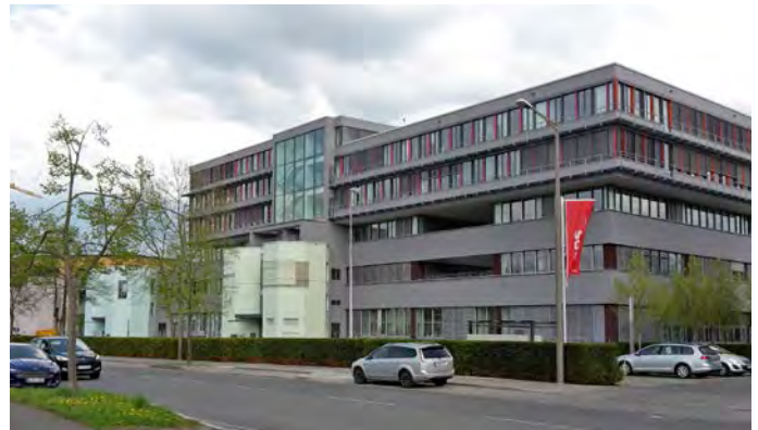
Neubau Bankgebäude und Sanierung der Grundig-Türme
