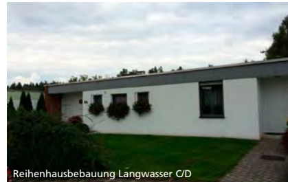
Reihenhausbebauung Langwasser C/D
