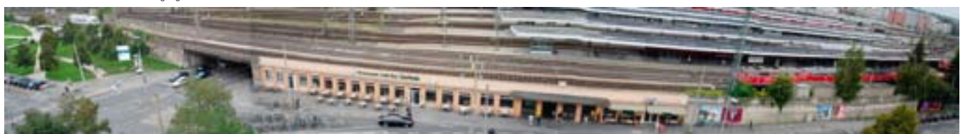
Nelson-Mandela-Platz Bahnhof Südzugang
