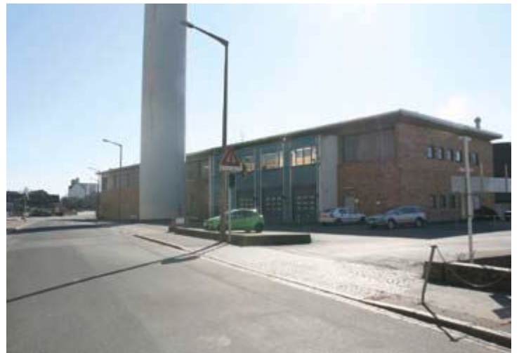
Heizhaus und Quellenturm an der Wandererstraße
