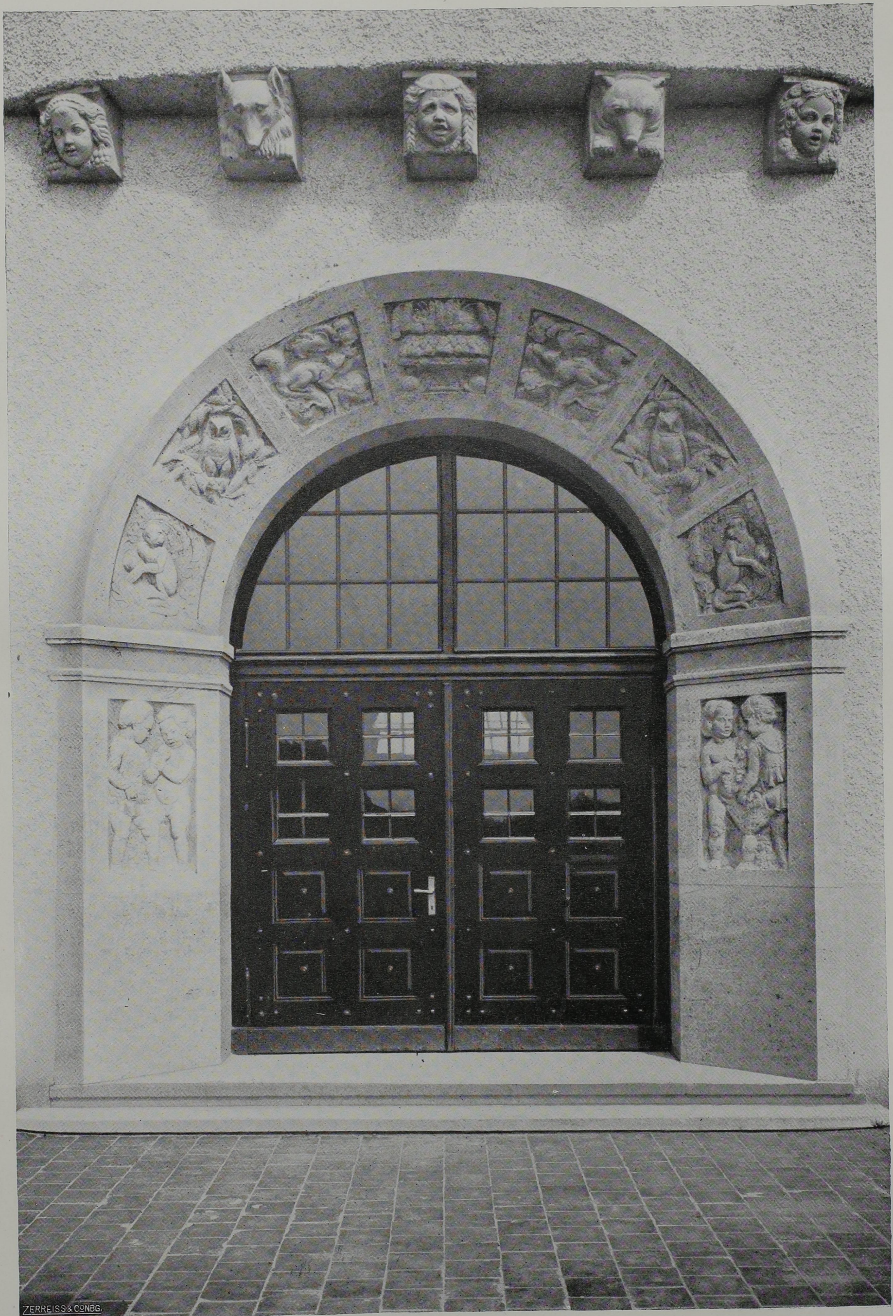
Schulhaus am Herschelplatz. (Portal.)
